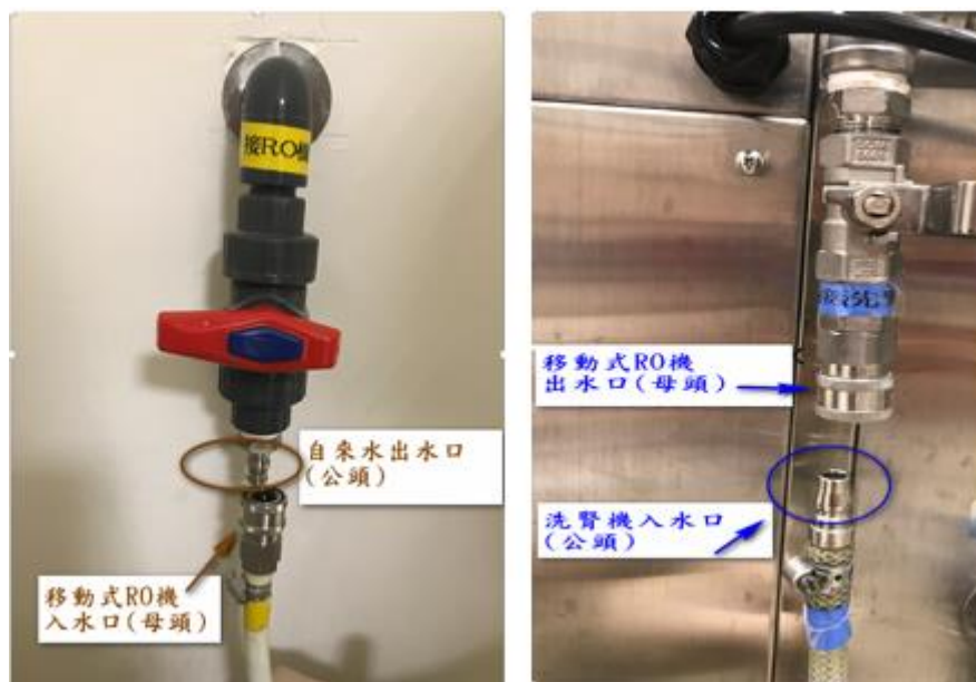
圖二 自來水出水口與洗腎機入水口皆為公頭以防止銜接
